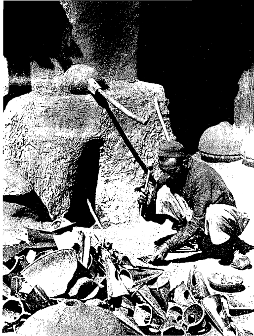
Abb. 20. Der intakte Schmelzofen mit dem Hitzeschild und mit der tief ausgebrochenen Abstichöffnung. Auf dem Ofen die Gießpfanne. Der Gießer zerschlägt vergossene Stücke zu Gußbruch
