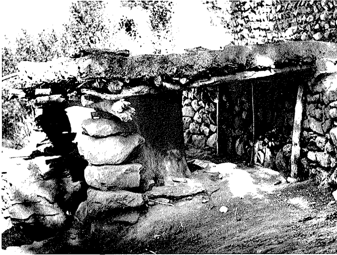
Abb. 11. Der Hoehofen von rechts, auf der Plattform aufgenommen. Auch auf dieser Seite des Ofens wird ein Loch für den Einsatz eines der drei Gebläse sichtbar, rechts neben dem Ofen die große Öffnung zum Beschieken, die schräg nach links unten geführt ist
