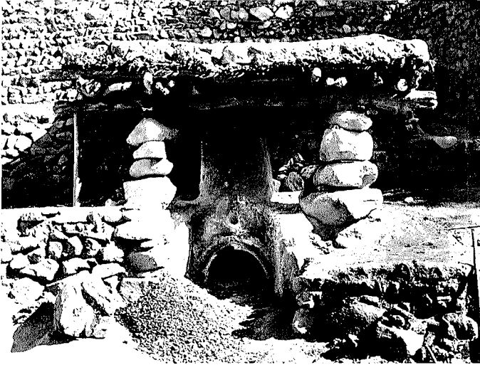
Abb. 10. Der Hochofen in Ariana, von vorn. Das Dach ist durch zwei trockengemauerte Pfeiler gestützt. Über dem Loch zum Ausräumen ein kleineres für den Einsatz eines Gebläses. Auf halber Höhe des Hochofens die Plattform, auf der links neben dem Ofen das Loch zum Beschieken sichtbar wird. Im Vordergrund Schlacken
